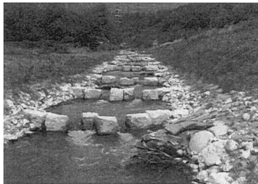
Passe à poissons naturelle au barrage de Winznau près d'Oltten (Alpiq)
