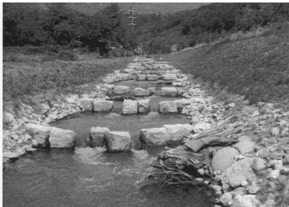
Passe à poissons «rivière artificielle» au barrage de Winznau près d'Olten (Alpiq)
