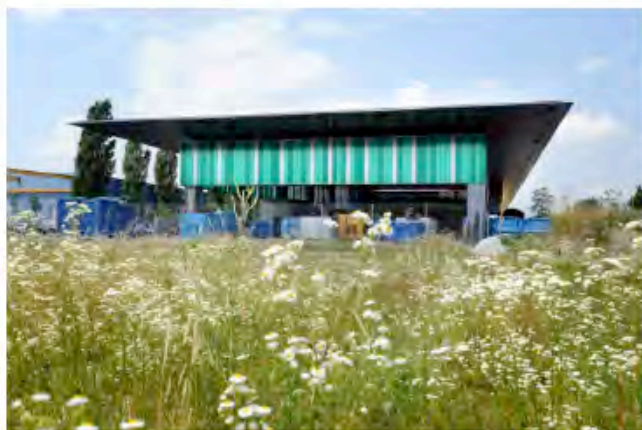
© Assainissement Lausanne / Christophe Chammartin
