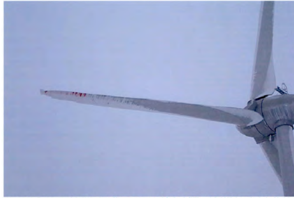
Ici le givrage d'une enercos à St-Brais : http://www.meteotest.ch/uploads/RTEmagicP_2010_ice_stbrais_ik_02.JPG
