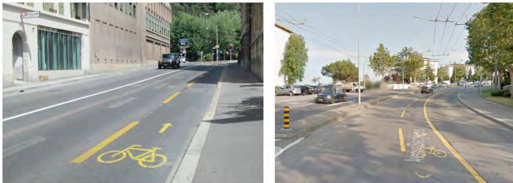
Rue Saint-Martin – suppression d'une présélection au profit d'une remontée de file pour vélos en 2015
