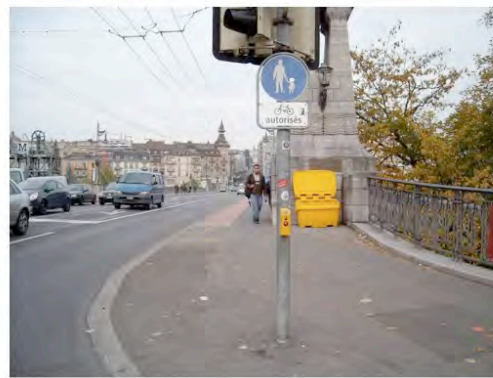
Pont Chauderon – trottoir autorisé aux vélos
