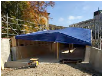
Passerelle de Maillefer – en construction
