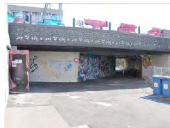
Passerelle et liaison du Martinet – 2015
