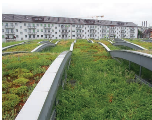
| Le substrat de la toiture du dépôt de tram BVB à Bâle est composé de paille de roseau de Chine et de matériaux minéraux légers. L'ensemencement a été réalisé avec de la fleur de foin (travaux en 2010). |
