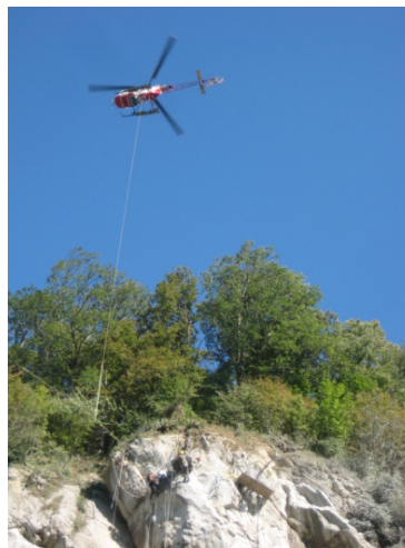
Travaux de sécurisation sur le rocher surplombant l'usine de Lavey
