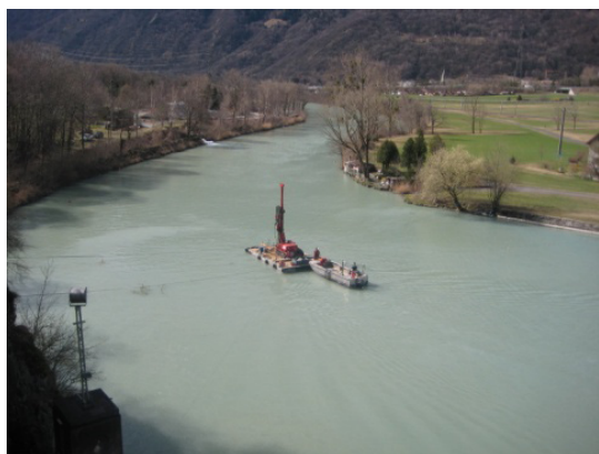
Forages dans la zone du barrage
