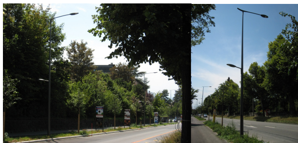
Avenue du Bugnon (luminaires équipés de lampes iodures métalliques « CPO »)
