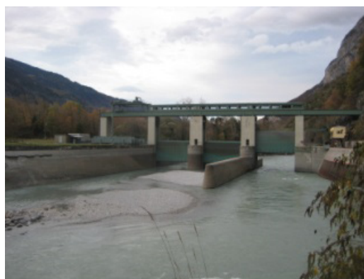
Le barrage de l'aménagement de Lavey avec les trois passes ouvertes pour l'arrêt de l'usine
