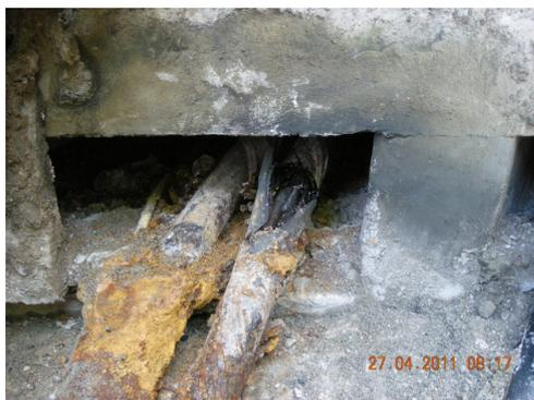
Avarie sur un câble à moyenne tension due au vieillissement (zone Borde-Villette)
