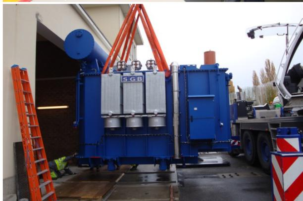
*Poste « Expo » : installation d'un nouveau module GIS (gas insulated switchgear) 50 kV et du nouveau transformateur de 25 MVA*
