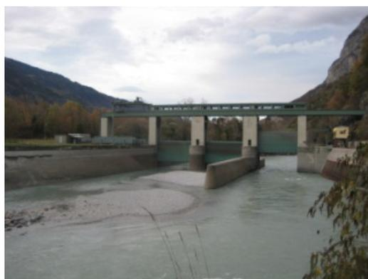
*Le barrage de l'aménagement de Lavey avec les trois passes ouvertes pour l'arrêt de l'usine*
