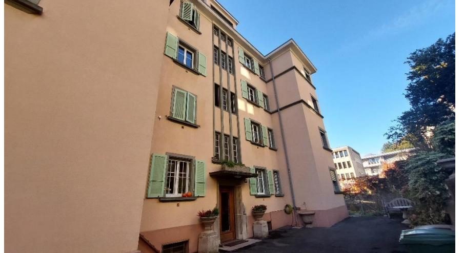
Façade nord et entrée
