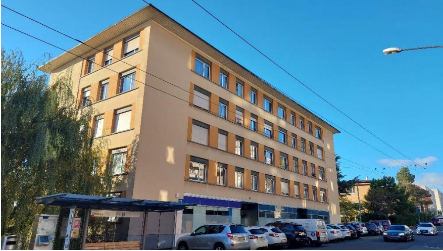
Façade nord-est et entrée
