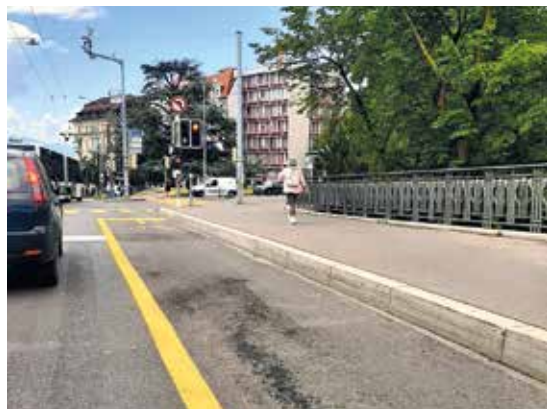
Bande cyclable sur le Pont Chauderon ©Ville de Lausanne
