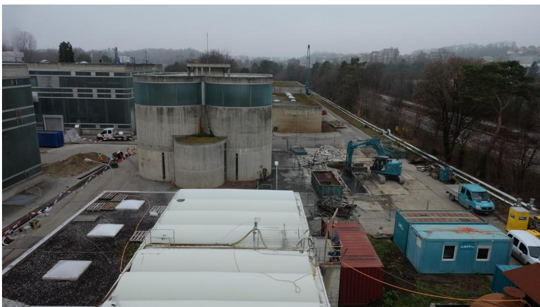
Déplacement de conduites et démolition de l'installation de traitement des huiles usées le 08.12.2015
