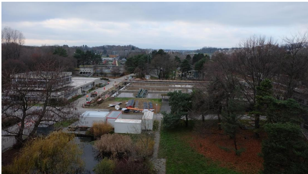
Déplacement de conduites en cours le 27.11.2015
