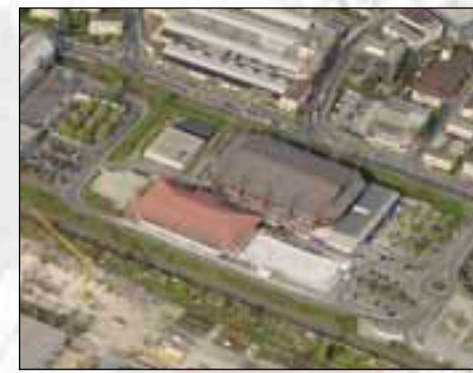
Malley Piscine olympique et centre de glace
