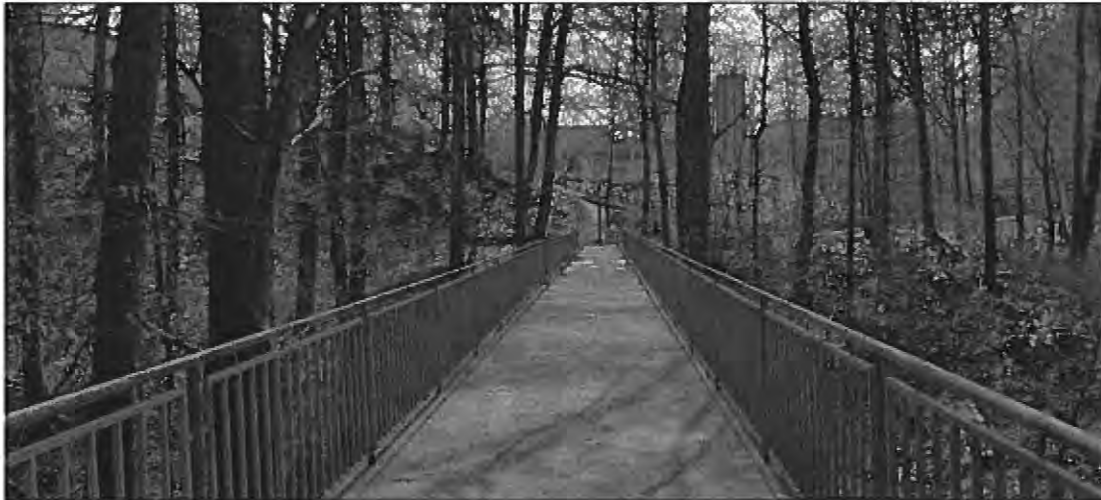
Pas de lampadaires/lumières sur le pont.
