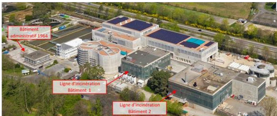
Figure 4 : bâtiment d'incinération n°1 prévu d'être démolé et remplacé par un nouveau bâtiment servant d'atelier et magasins
